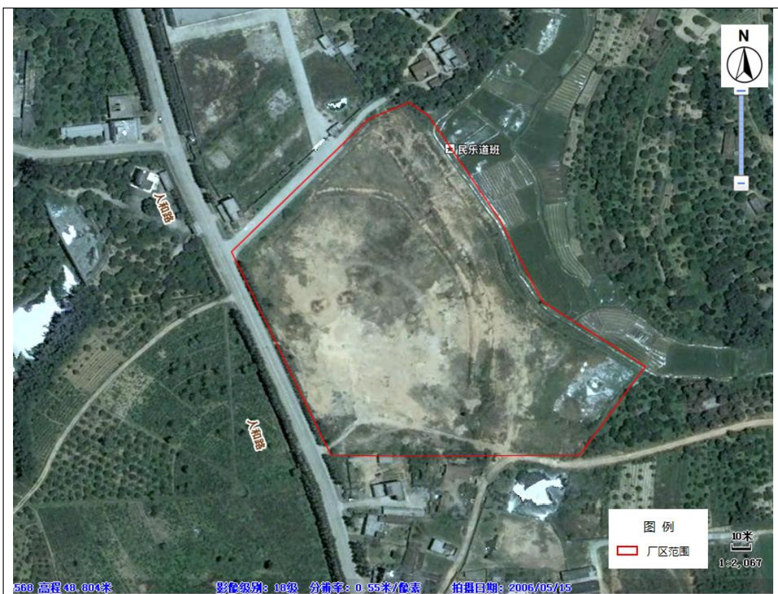
2006 年 5 月历史影像图（地块为荒地）
